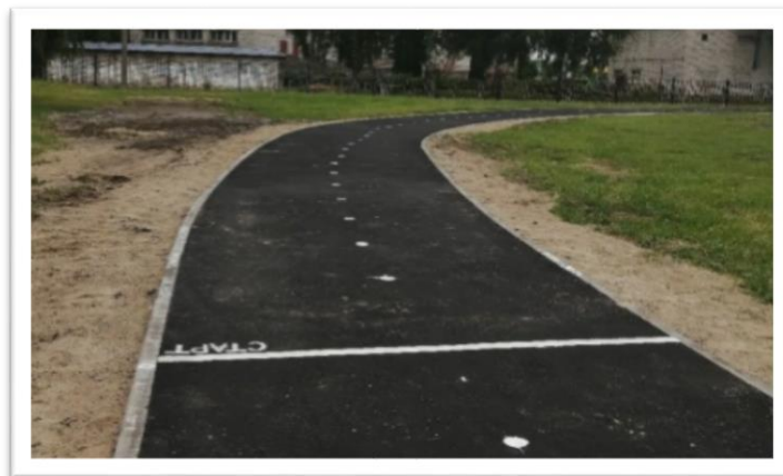
ОТРЕМОНТИРОВАНА БЕГОВАЯ ДОРОЖКА ШКОЛЫ № 30
