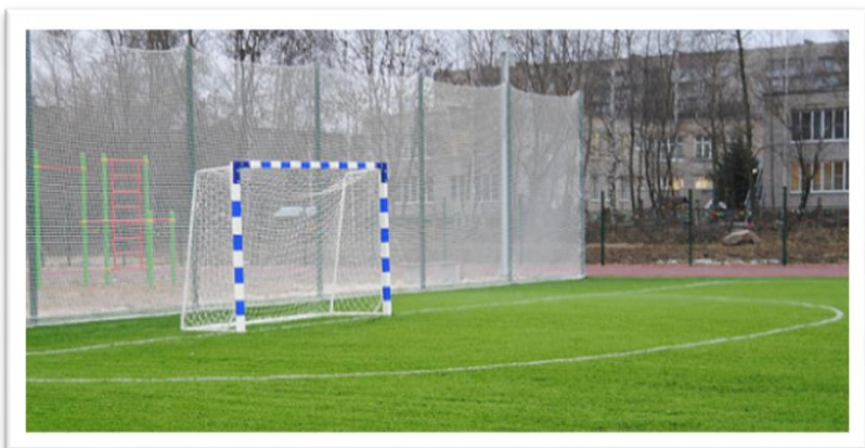
БЛАГОУСТРОЕНА ТЕРРИТОРИЯ МЕЖДУ ГИМНАЗИЕЙ № 18 И ШКОЛОЙ № 28.
