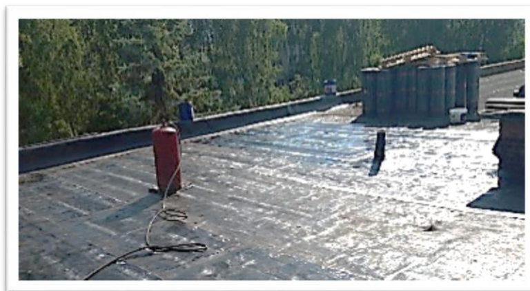
РЕМОНТ КРОВЛИ ДЕТСКИХ САДОВ №№ 38, 83, 97, 107, 109, ШКОЛЫ №44. ДОШКОЛЬНЫХ ГРУПП ГИМНАЗИИ №18.
