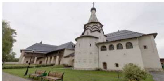
Архитектурный ансамбль в Суздале
